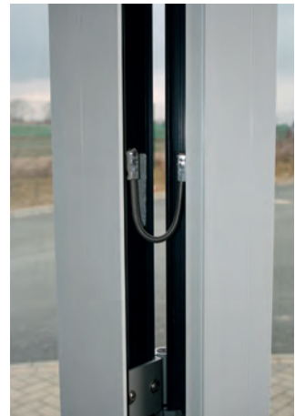
Abb. 32: Kabelführung Rahmen – Flügel
